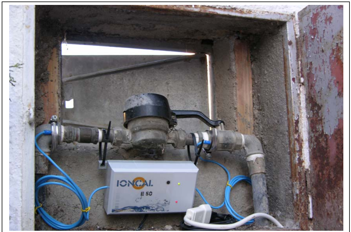
C/ Abeto, 5 o 7 Urbanización Buenavista. Ogijares, Granada. Junio 2008 Detalle de Anti-incrustante IONCAL E-50 montado sobre contador de agua de Ø 15 mm de cobre de entrada general.
